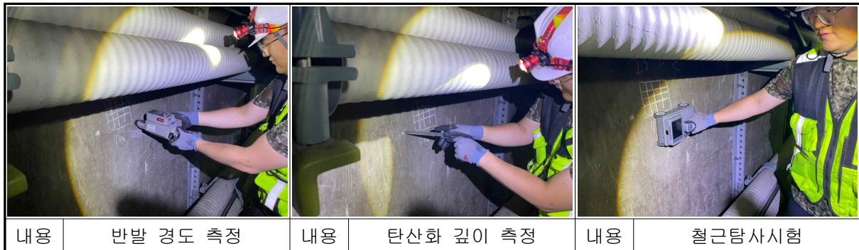
【사진 4.4】 능곡S/S인출 전력구 재료시험 전경
